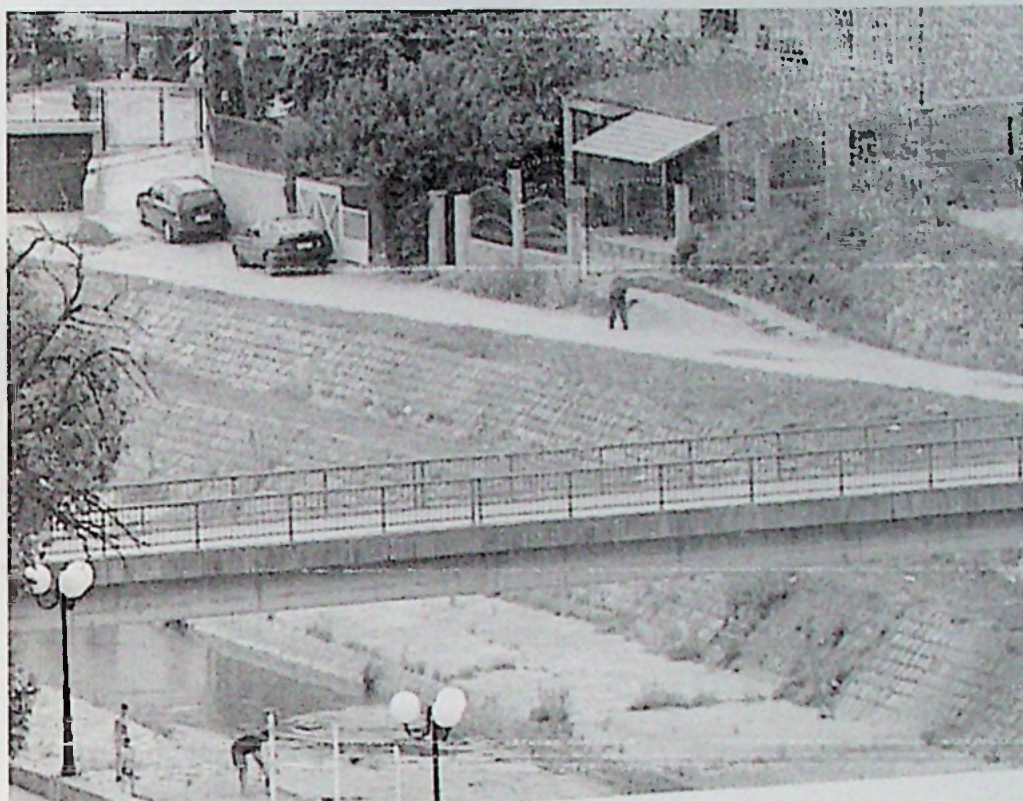
Бетонски мост на месту порушено "Даскаловог" моста
