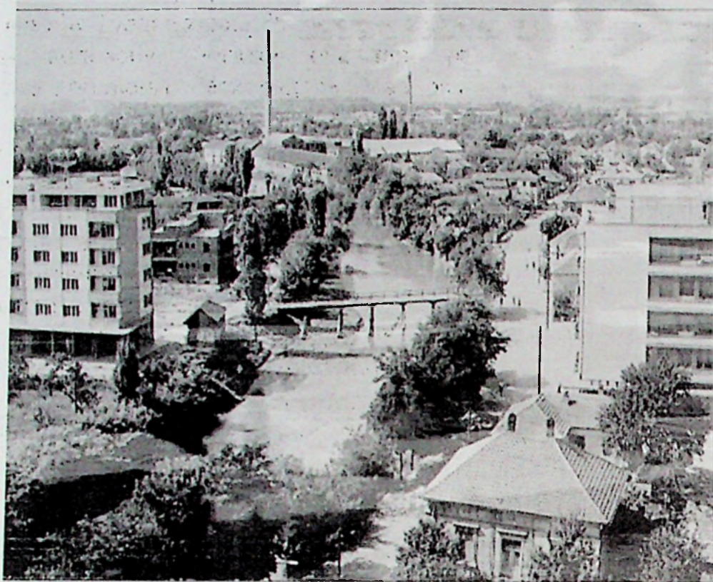
"Каспаров" мост низводно од "Северног блока 1"
