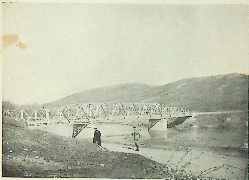
Мост на Вардару, на путу: Ђевђелија—Богданци—Дојран.
